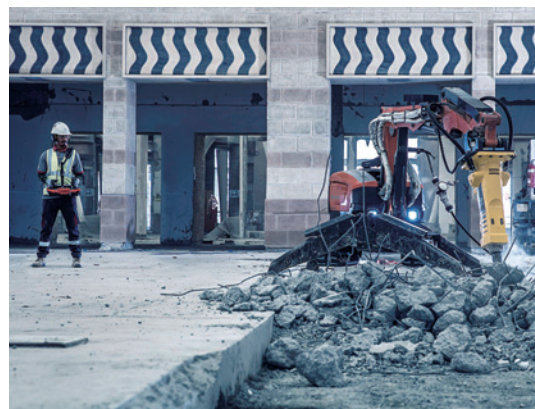
DXR 270 による解体作業の様子（ドバイ）
