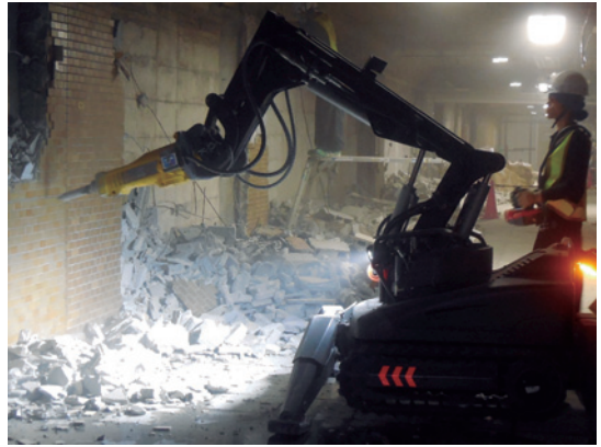
DXR 140 による屋内解体作業の様子 (日本)
